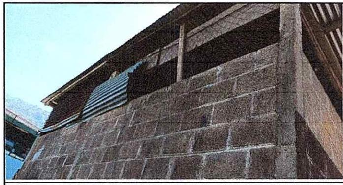
FOTO 12. Las paredes de aulas se encuentran en mal estado por el paso del tiempo. Es necesario el mantenimiento.
