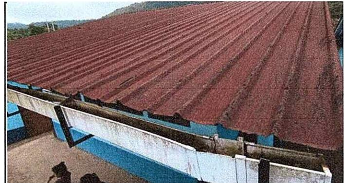
Fotos 4: la cubierta de lámina de un modulo ya esta muy gastada y cuando llueve fuerte se dificulta por las goteras.
