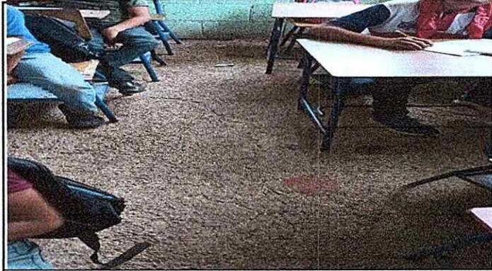
Foto 7: el entortado de las aulas esta en mal estado y necesita intervención inmediata.
