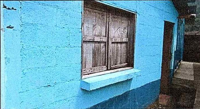
Foto 1: Las puertas y ventanas presentan daños severos por el paso del tiempo.
